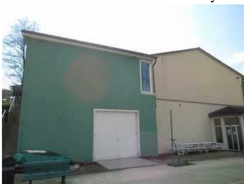
přístavba čelní pohled
