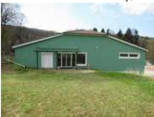
přístavba boční pohled
