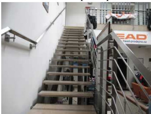
1.NP - schodiště do 2.NP
