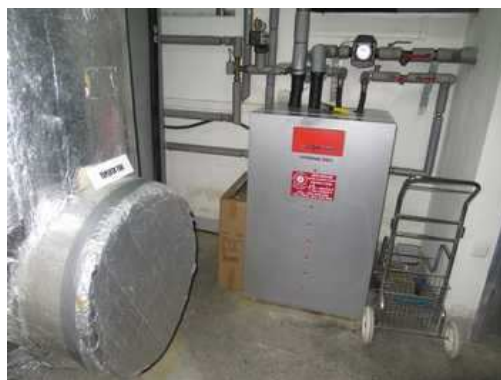
1.PP - tepelné čerpadlo
